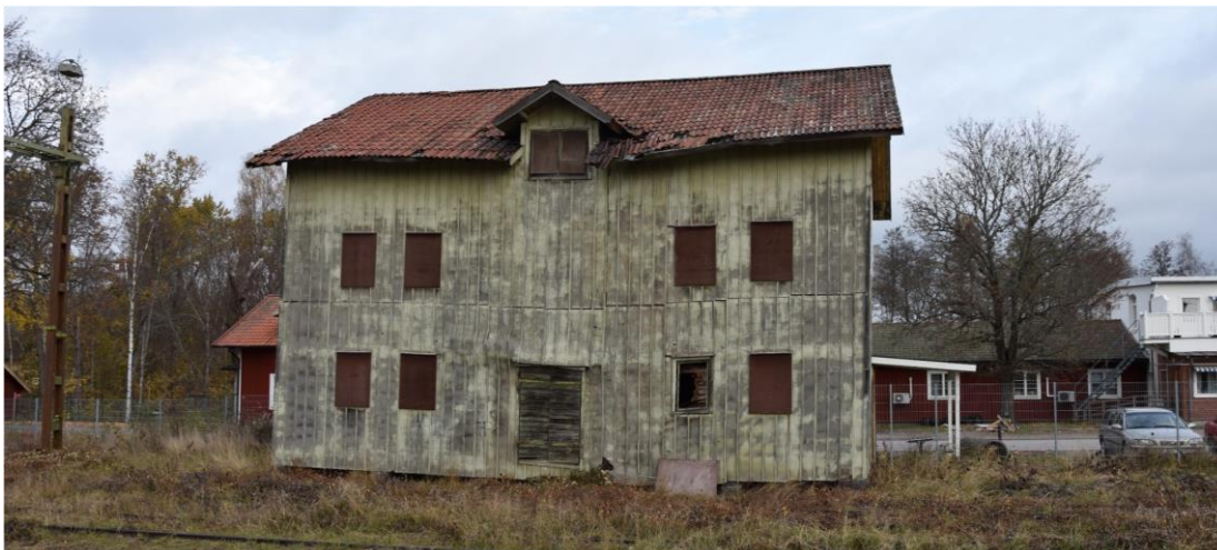
Figur 9. Det gröna kolhuset/godsmagasinet/södra fasad.
