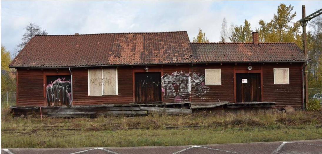
Figur 8. Det röda godsmagasinet/södra fasad med raserad lastbrygga av trä synlig.
