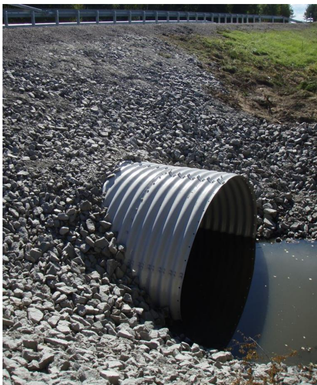
Figur 6 - Befintlig rörbro 100-17385-1 Bro över Hasslebäcken, nedströmsvy mot sydöst.
