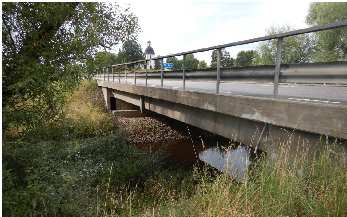
Figur 2 – Befintlig balkbro 16-131-1 Bro över Friaån.
