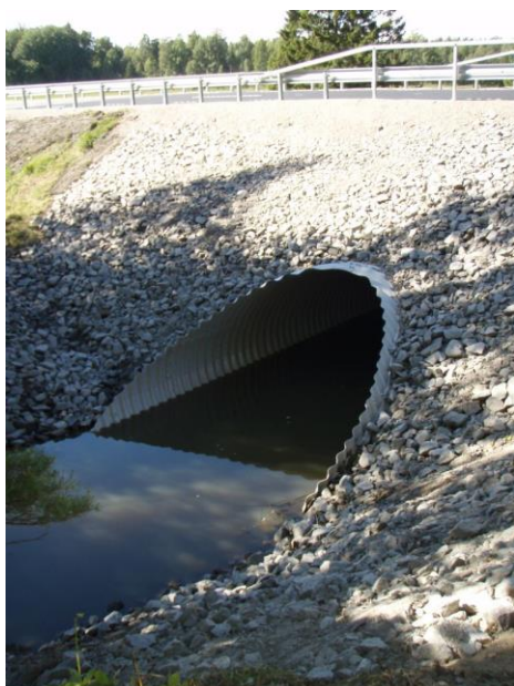
Figur 5 – Befintlig rörbro 100-17385-1 Bro över Hasslebäcken, uppströmsvy mot sydväst.
