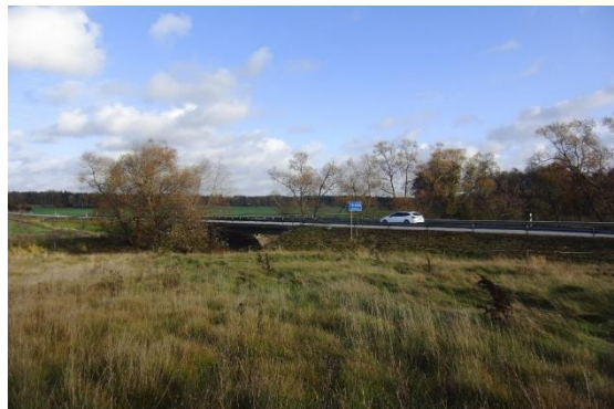
Figur 15. Strax norr om Enåsa kyrka passerar väg 26 över Friaån på en befintlig betongbalkbro.
