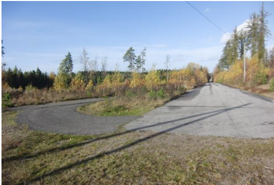
Figur 17. Söder om Sjötorp korsar väg 26 gamla väg 64, vilken skurits av vid anläggandet av väg 26 så att ingen anslutning finns mellan de båda vägarna. På fotot syns den del av väg 64 som fortsätter norrut och vidare in mot Sjötorp.
