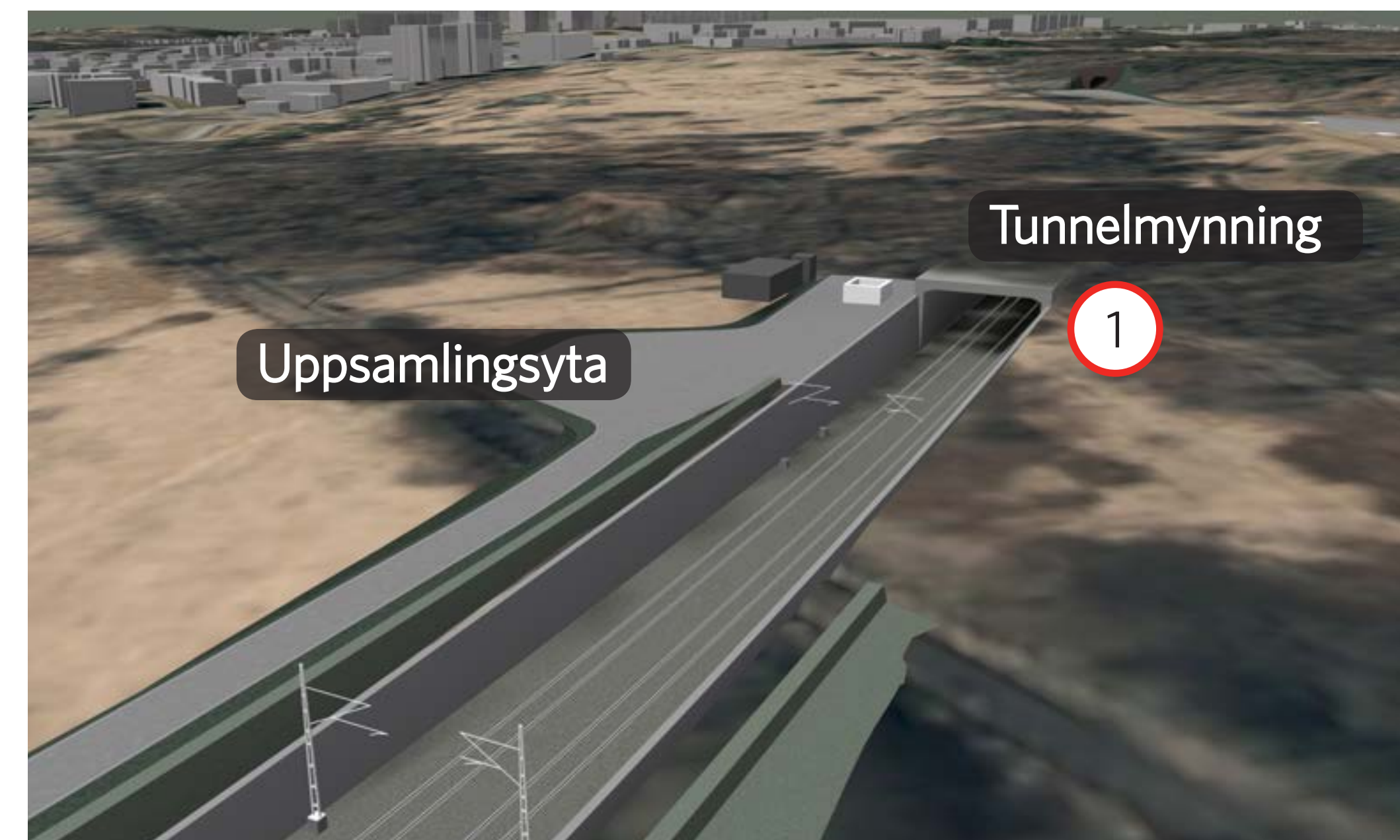
Mynningen i järnvägstunnelns södra ände, med uppsamlingsyta och teknikbyggnad. Området kommer att inhägnas.
