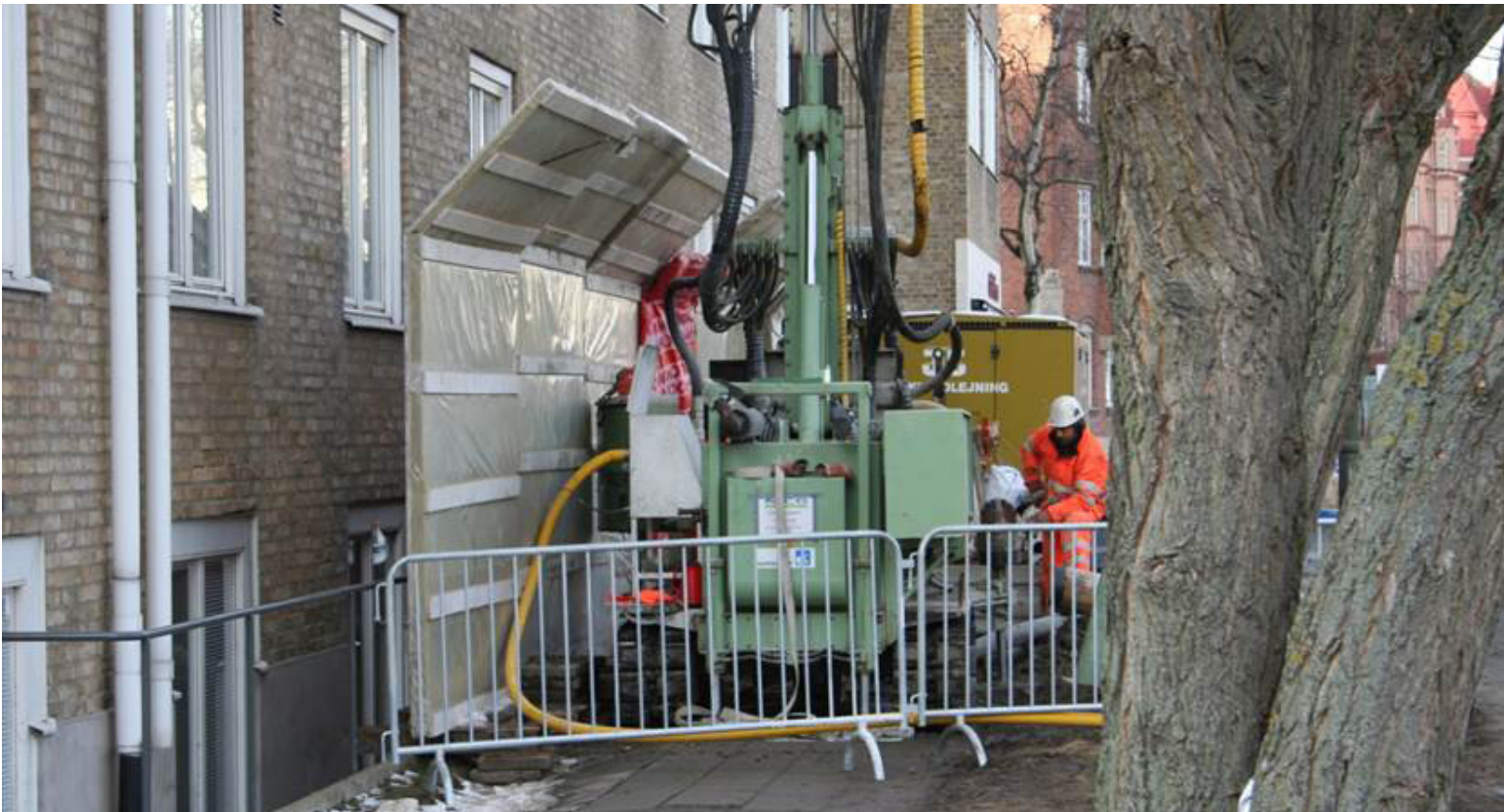
Exempel på bullerskyddsskärm vid byggarbete nära bostadshus.
