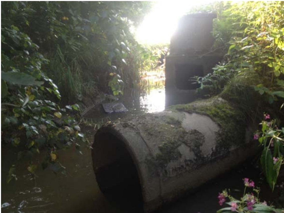
Foto 32. Inkommande trummor till Lassabäcken nedströms järnvägskorridoren.
