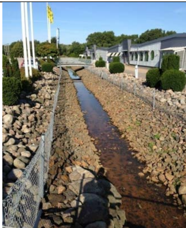
Foto 37. Den annorlunda erosionskyddade delen av Lassabackabäcken.
