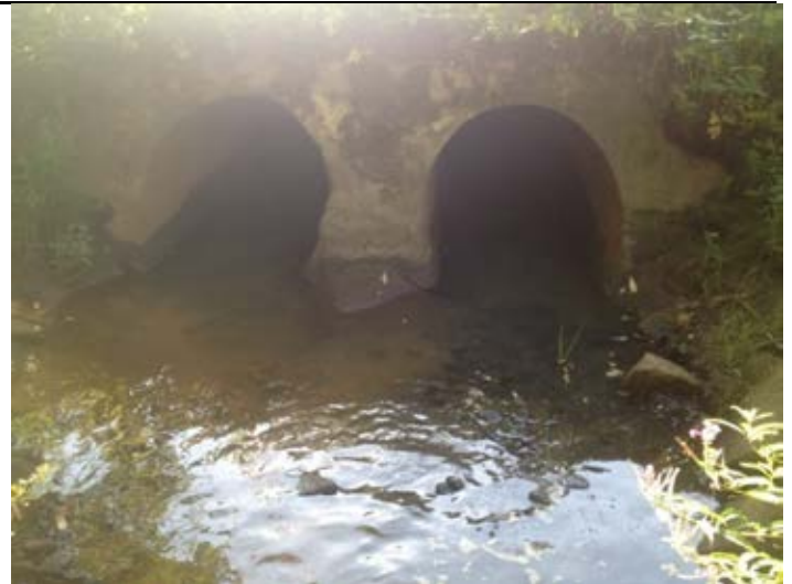
Foto 36. Lassabäcken utlopp under befintlig järnvägskorridor.
