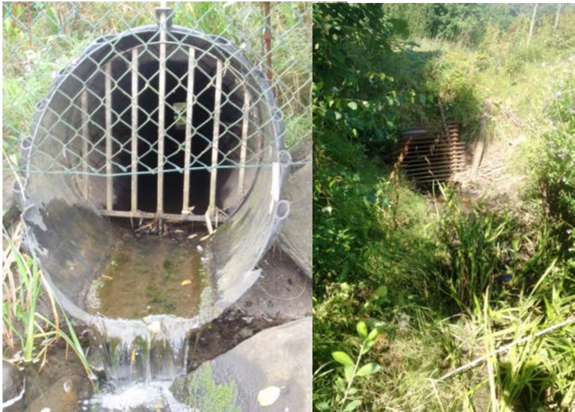
Foto 16. Utloppet i Brearedsdammen (vänstra fotot) och inloppet till den trumma vars utlopp visas till vänster (högra fotot). Båda utgör partiella vandringshinder (definitiva för större öringar).
