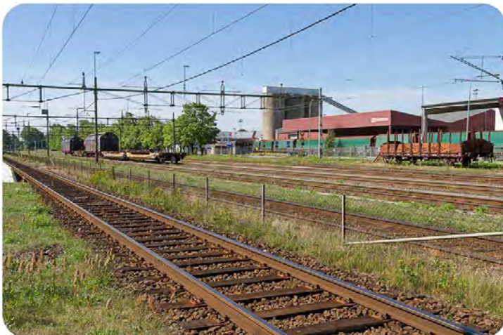
Figur 20. Mittenområdet Varbergs station, utsikt åt söder.
