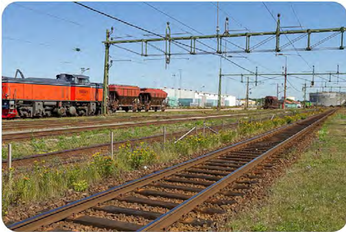
Figur 19. Mittenområdet Varbergs station, utsikt åt norr.
