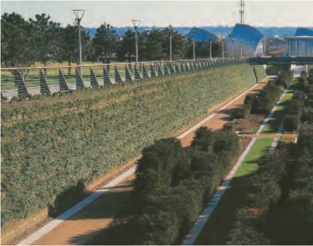
9.2:5 Exempel på brant lutande "grön mur". Thames Barrier Park, London. (Ur Byggekunst nr 7, 2001.)
