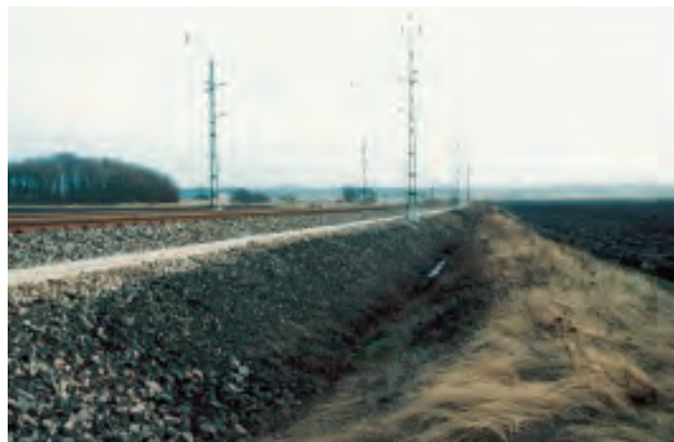
9.2:15 Ny Väst kustbana, som här norr om Varberg, kräver bredare spårbank och djupare diken.
