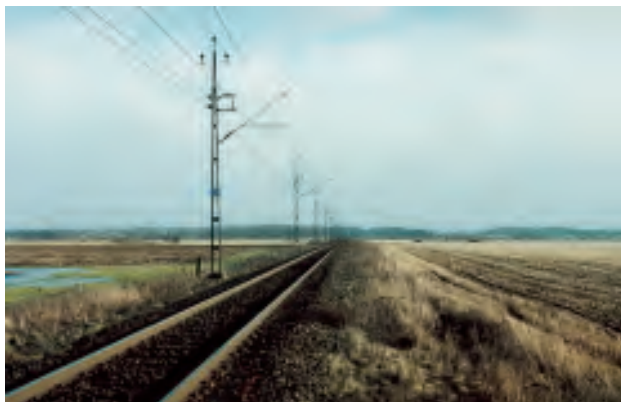
9.2:14 Befintlig järnväg söder om Varberg ligger diskret i landskapet.
