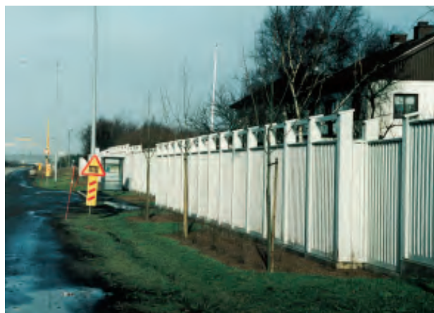
9.2:3 Befintlig bullerskärm utmed gamla E6 vid norra infarten till Varberg är väl anpassad till bakomliggande bebyggelse.
