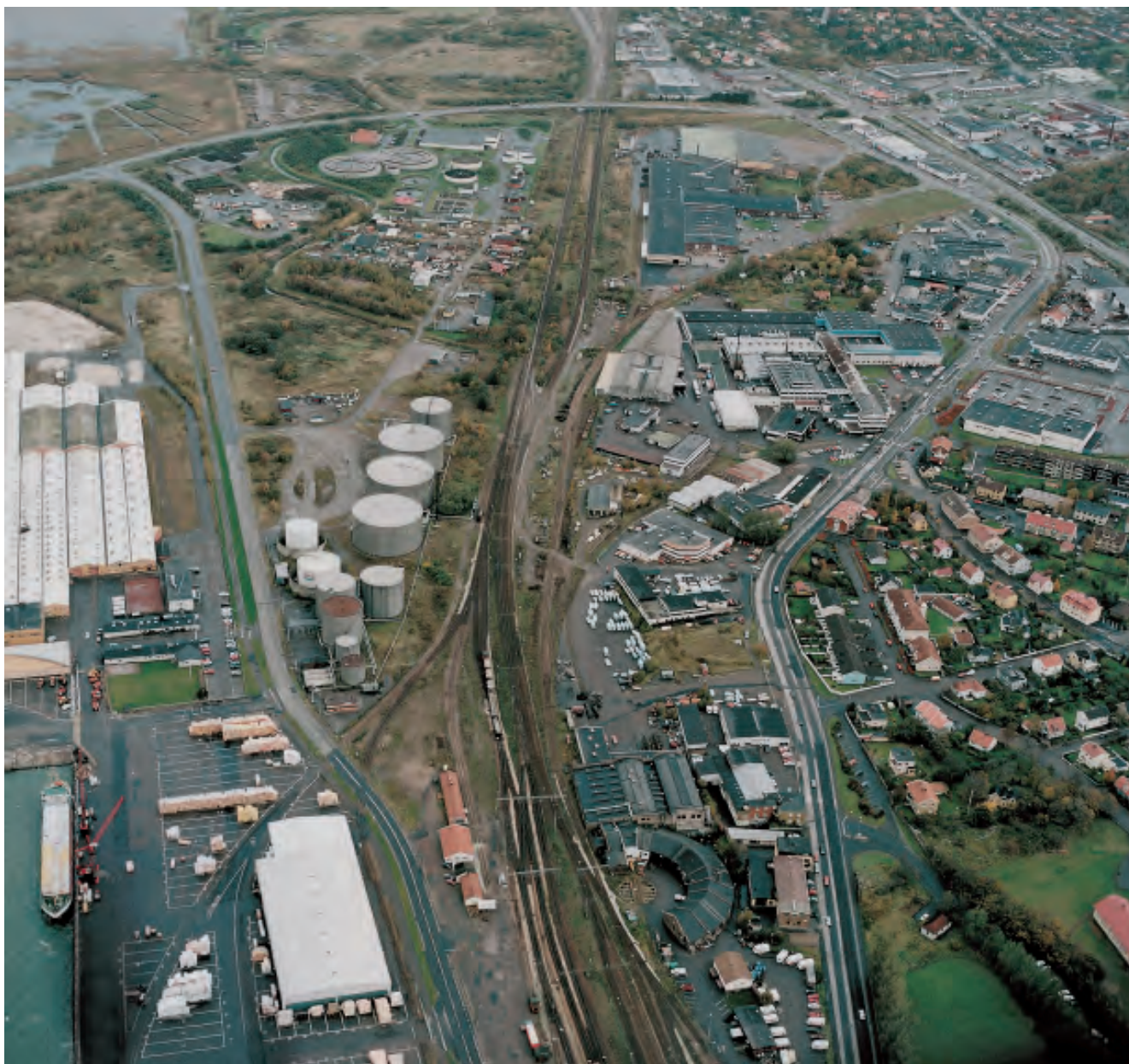
3.5:2 Flygbild över industriområdet längs befintlig järnväg norr om nuvarande stationsområde. (Vissa av oljecisternerna är i dag rivna.)
