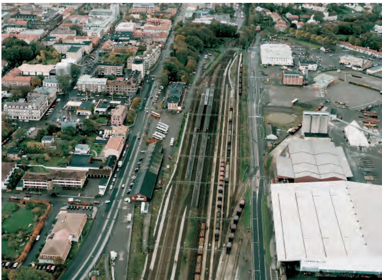
3.2:2 Nuvarande bangård och stationsområde med befintlig järnvägsstation och bussterminal mitt i bild. (Godsmagasinet i bildens mitt finns inte i dag.)
