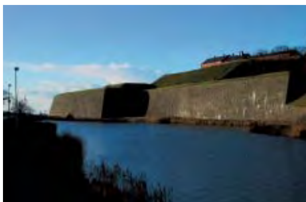
2:3 Varbergs fästnings bastanta bastioner.
