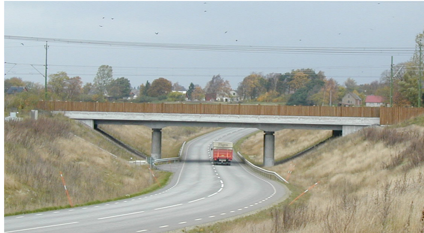
Figur 4.91. Exempel på utformning av trefacksbro i betong, med flacka slänter och gräs/ängsvegetation på mager jord. Österleden föreslås utföras med ännu något flackare slänter jämfört med illustrationen, och med transparenta bullerskydd på bron.
