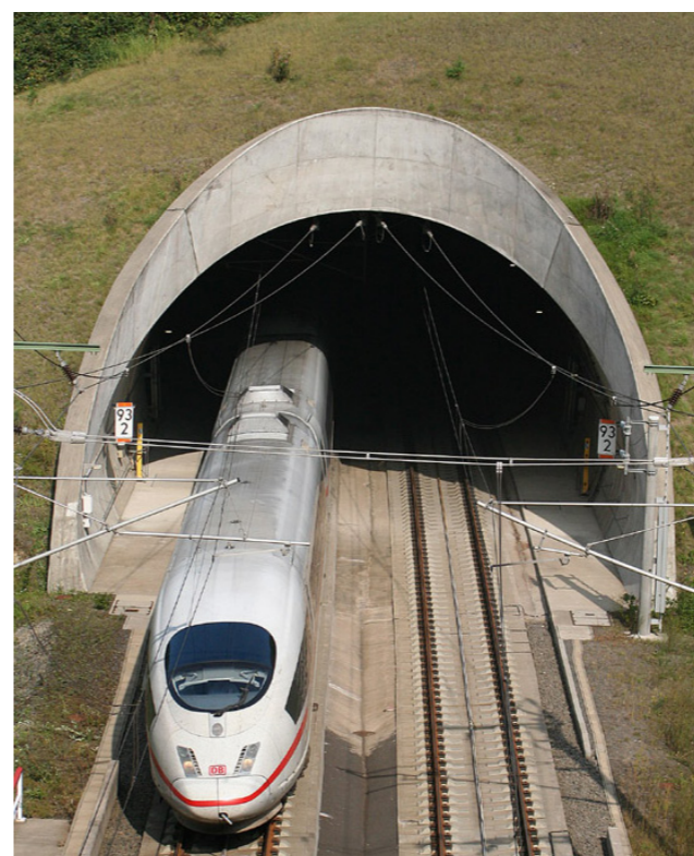
Figur 4.85. Liknande tunnelmynning, exempel från Tyskland.
