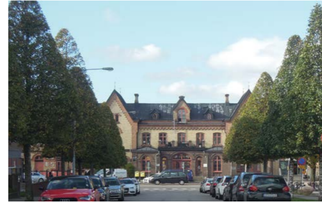
Figur 4.34. Befintligt stationshus i fonden av Eskilsgatan
