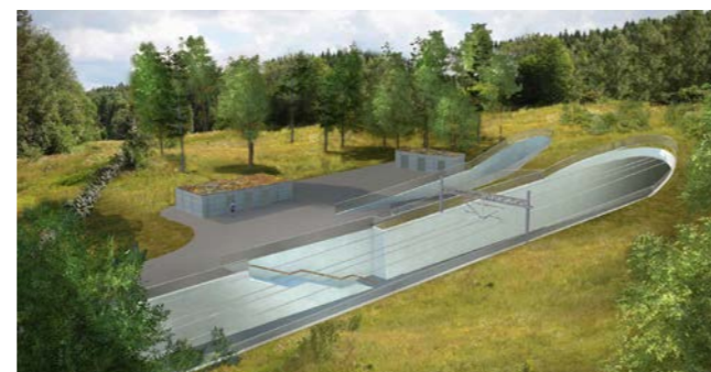
Figur 1.3. Tunnelmynningen i söder
