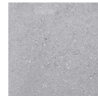
Väggar Ljus, slät betong
