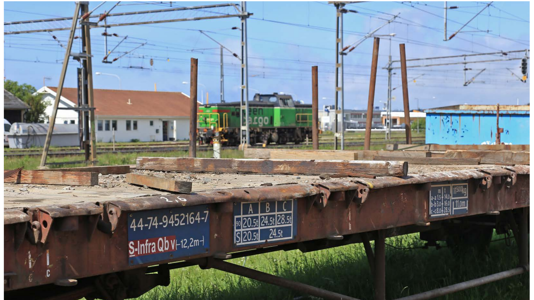
Figur 4.26. Typisk utblick över befintlig järnvägsanläggning i verksamhetsområdet. Foto Pär Connelid, Kula HB.
