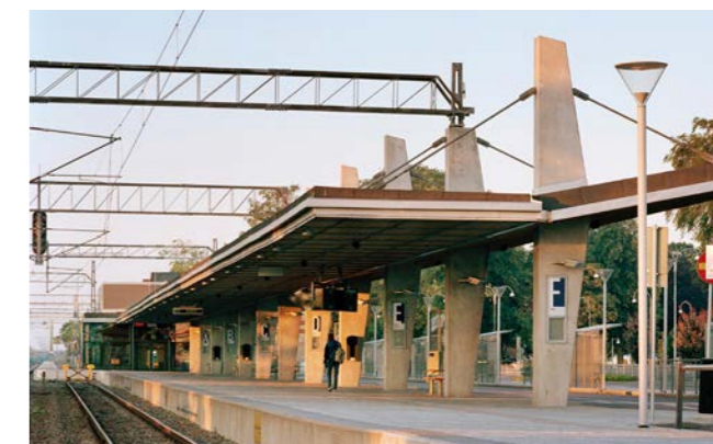
Figur 4.67. Tekniska anläggningar integreras med andra konstruktiva delar för att skapa en god helhetsgestaltning. Referens Kungsbacka resecentrum.
