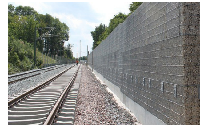
Figur 4.11. Gabionväggs släktskap med övriga material i järnvägsanläggningen är uppenbar.
