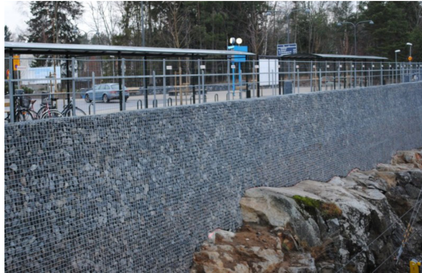
Figur 4.18. Exempel på gabionvägg ovanpå bergskärning. Gabionen ska ansluta väl till bergets profil, och hålla så hög kvalitet att yta och krön håller formen över tid.
