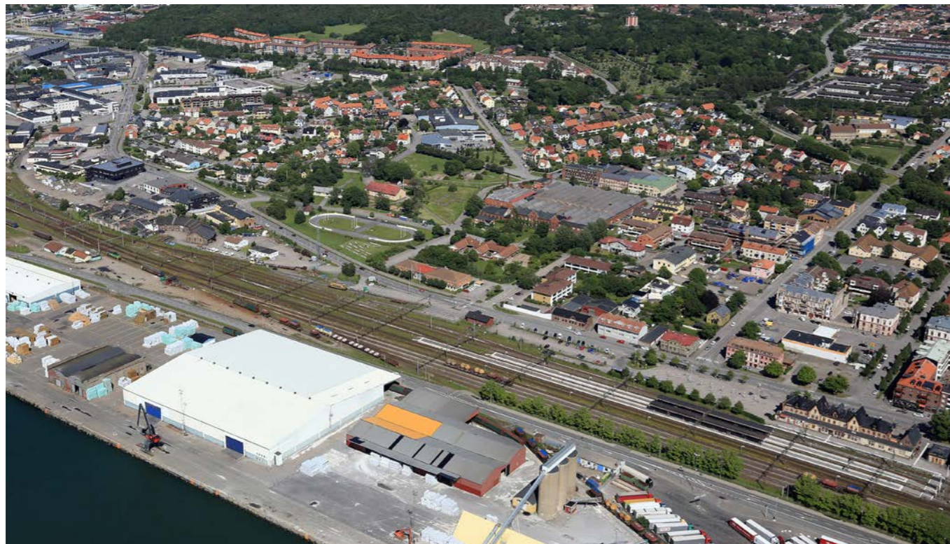
Figur 4.30. Foto, norra delen av Varbergs stationsområde idag, med nuvarande stationshus till höger i bilden. Källa: Pär Connelid, Kula HB
