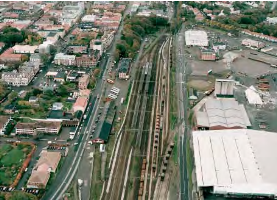
Ill. 3.2:2 Nuvarande bangård och stationsområde med befintlig järnvägsstation och bussterminal mitt i bild.
