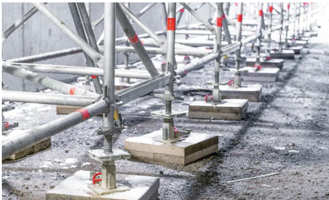
Figur 13. Exempel på hur en volymställning ser ut. Vid användning av en volymställning i ett vattendrag så står de kvadratiska stöden på botten av ån.
