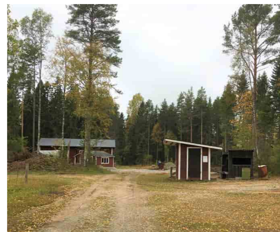
Figur 8.6.2 Skjutbanan vid Sandbäcken, vy mot byggnader.
