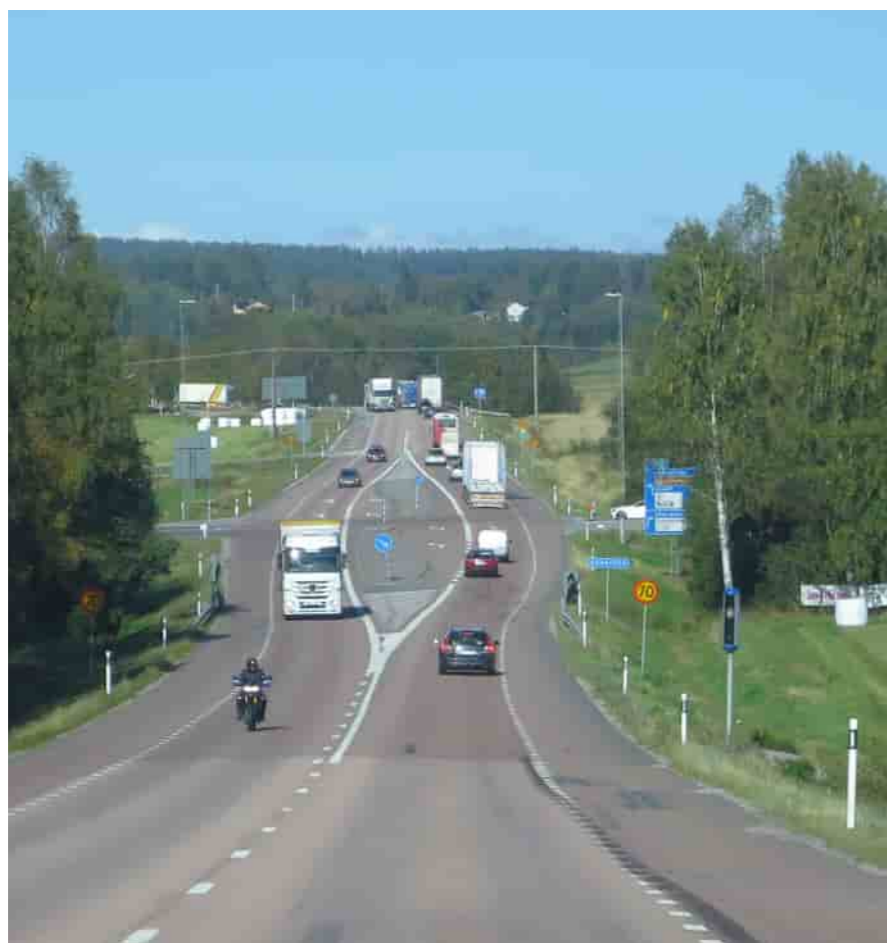
Figur 8.5.2 Dagens väg genom Gnarp erbjuder två större korsningar i plan. När dessa ersätts av planskilda passager bedöms att möjligheten till rörlighet för oskyddade trafikanter ökar. Detta kan gynna barn, äldre och personer med funktionsnedsättning.
