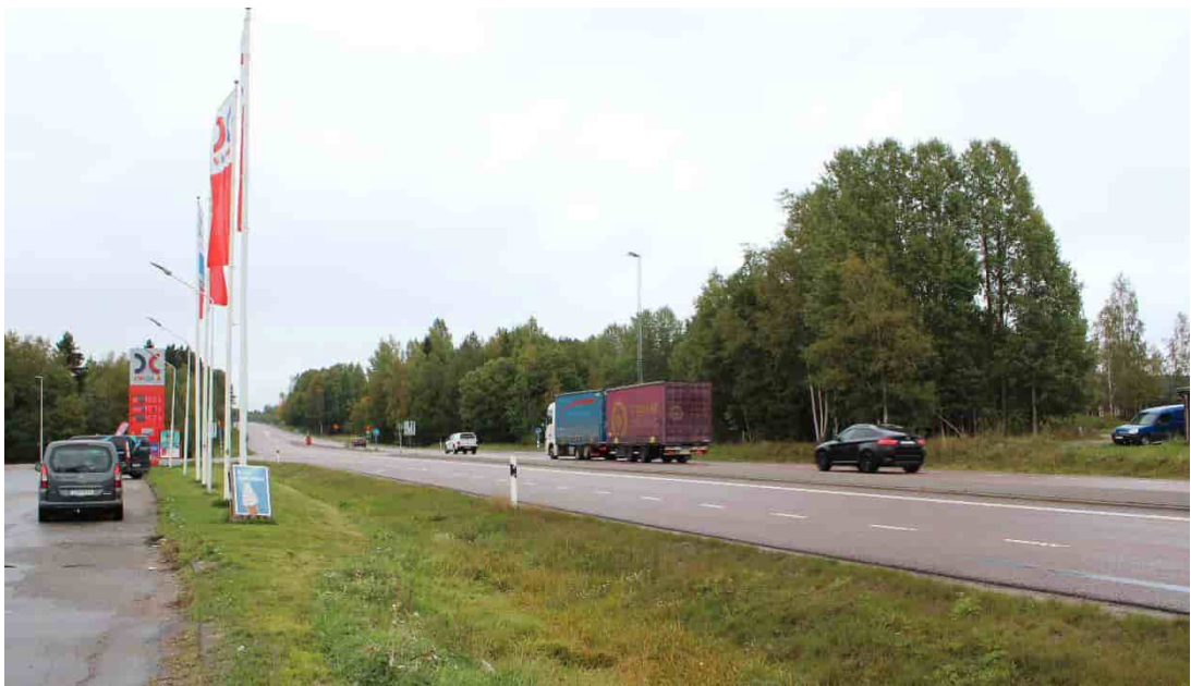
Foto 19. Befintlig E4 vid korsningen med Stationsvägen, läget för trafikplats Gnarp norra.
