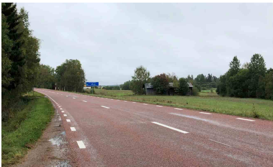
Foto 14. Bergsjövägen åt öster vid läget för ny trafikplats i Jättendal.
