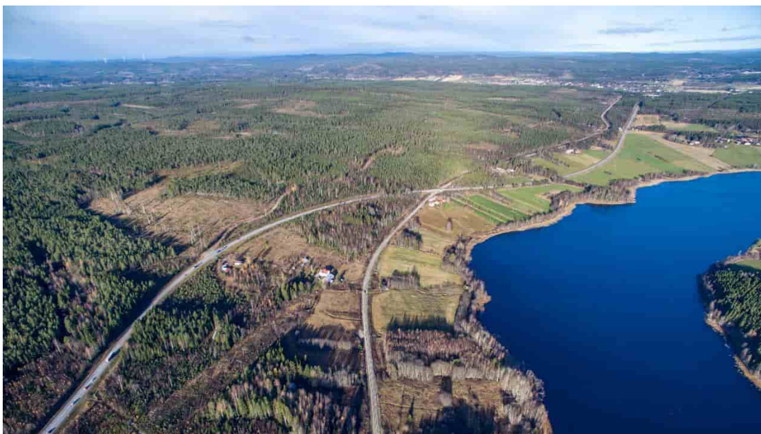
Foto 16. Befintlig E4 vid den så kallade "Bälingkurvan", bef. järnväg och Bälingsjön sett från söder.
