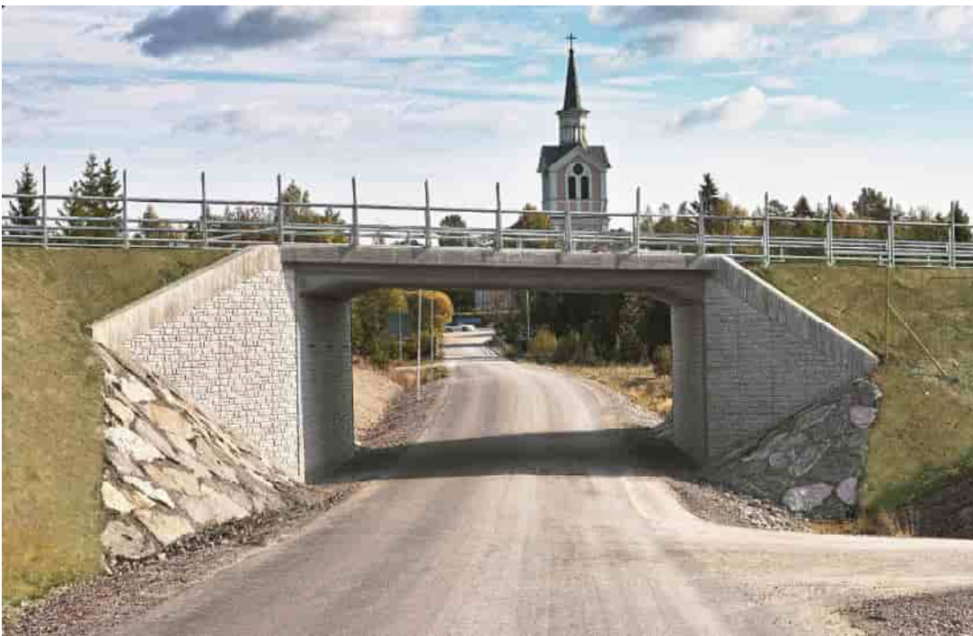
Foto 26. E4 på bro vid Njurunda med bearbetad betong och brokoner med fältsten.
