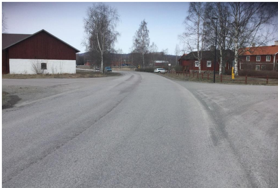
Figur 5; Korsning Väg 671-Bergsmansvägen
