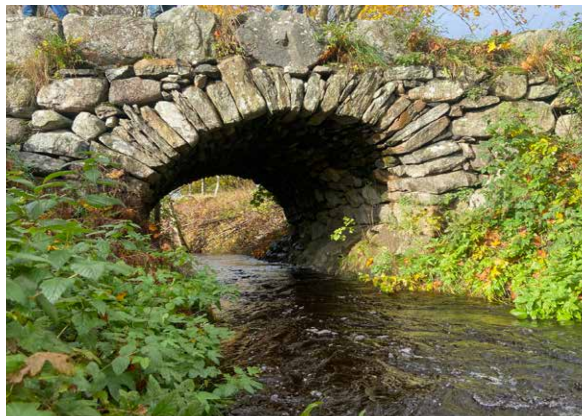
Bild 65. Befintlig stenvalvsbro
