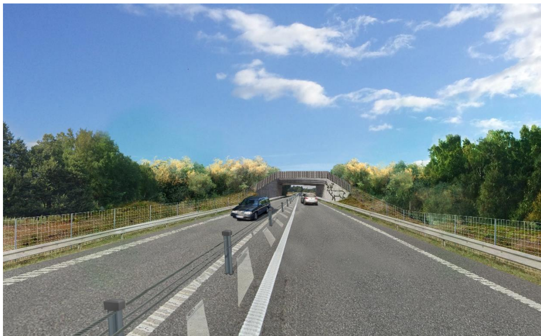
Figur 28. Exempel på utförande av faunapassage.
