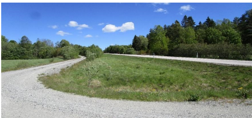
Figur 5.2-4. Befintlig enskild väg till fastighet 1:34.
