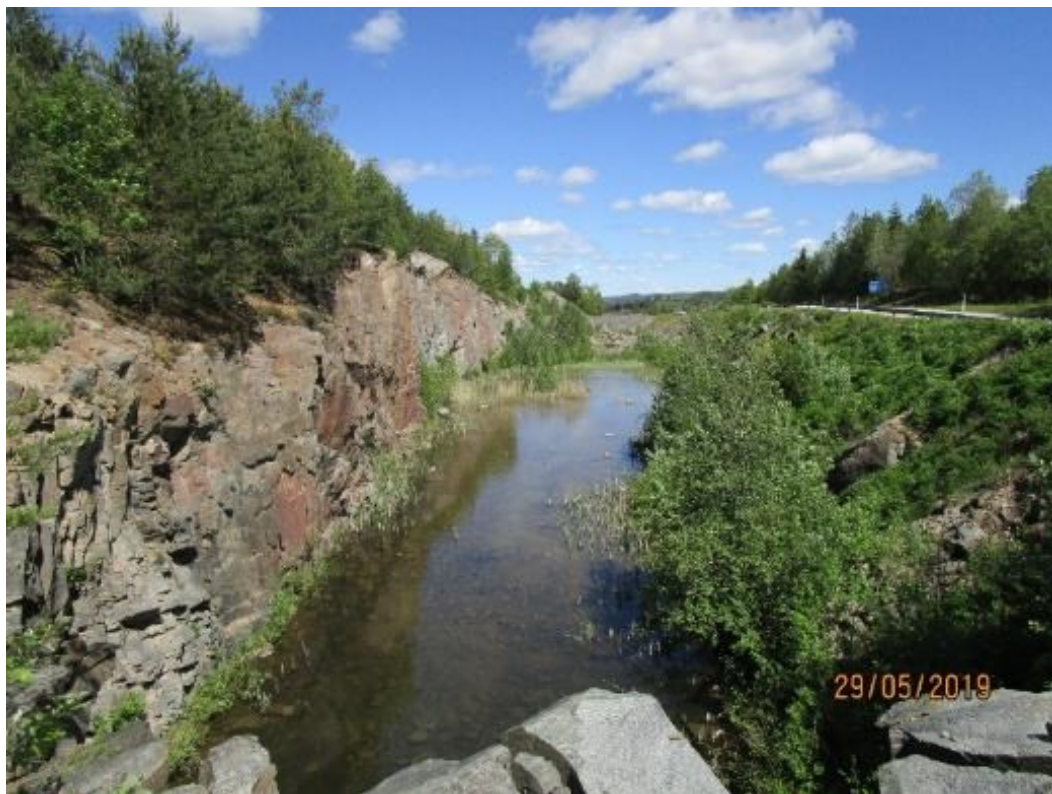
Figur 5.2-8. Tidigare berguttag med höga och branta slänter nära vägen.
