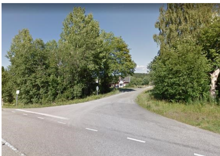
Figur 5.2-13. Befintlig busshållplats utan väderskydd mot Bäckefors vid korsningen med väg 2122.
