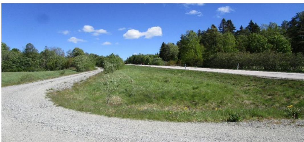
Figur 5.2-4. Befintlig enskild väg till fastighet 1:34.
