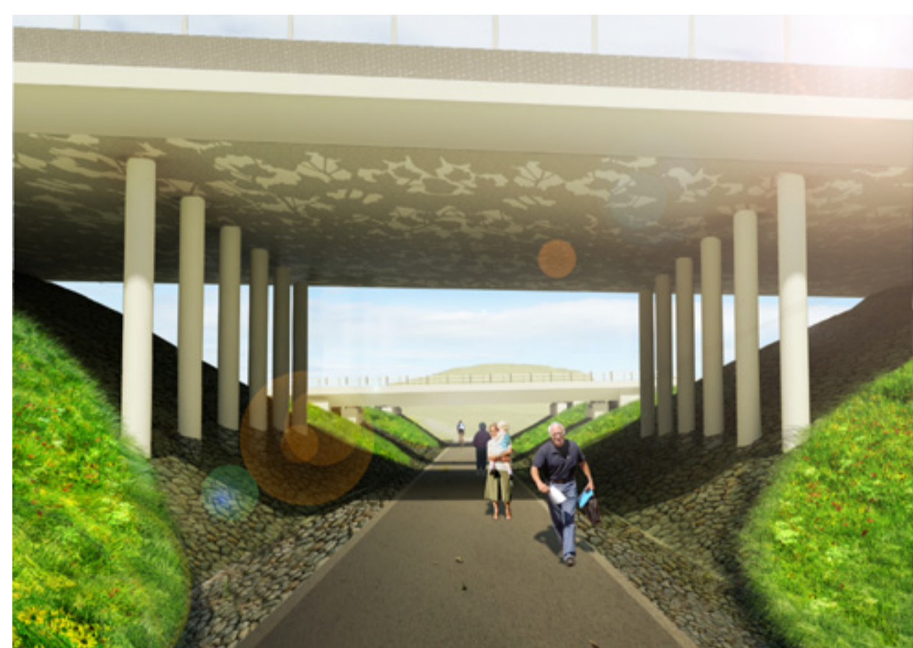
Gång- och cykelbana under trafikplats Skuru.
