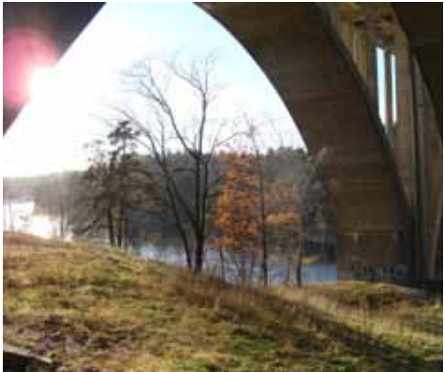
Figur 5.16 Utsikt söderut från berget under befintlig bro på Björknässidan.
