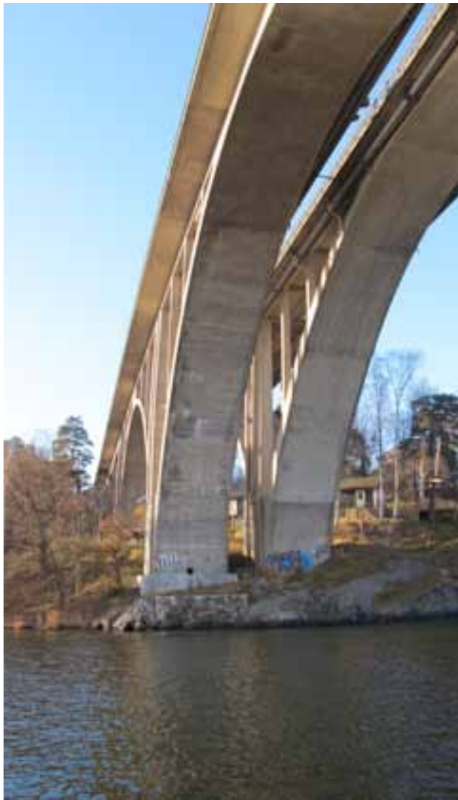
Figur 3.19 Homogena granithällar vid brofästet på östra sidan.
