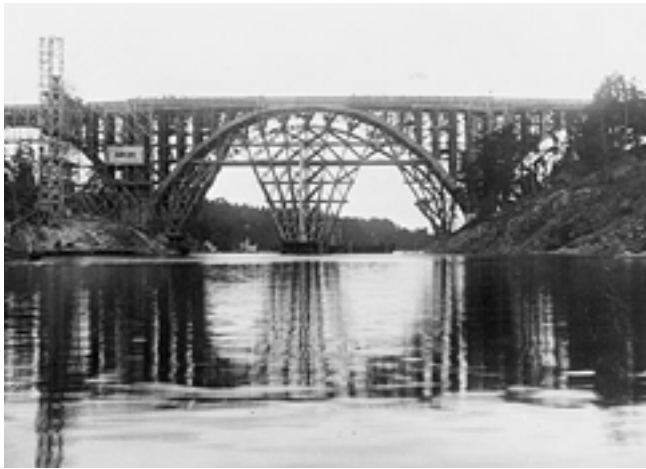
Figur 1.4 Skurubron under konstruktion år 1913-1915.
