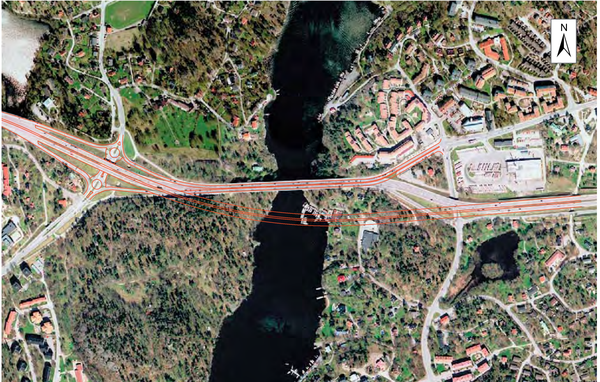
Ny friliggande bro och en ofullständig trafikplats i Skuru med ramper i riktning mot Stockholm
