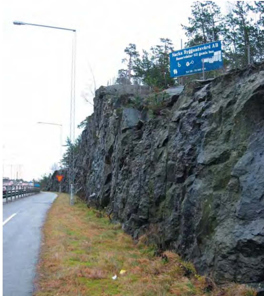
Bergskärning söder om Värmdöleden på Skurusundets västra sida
