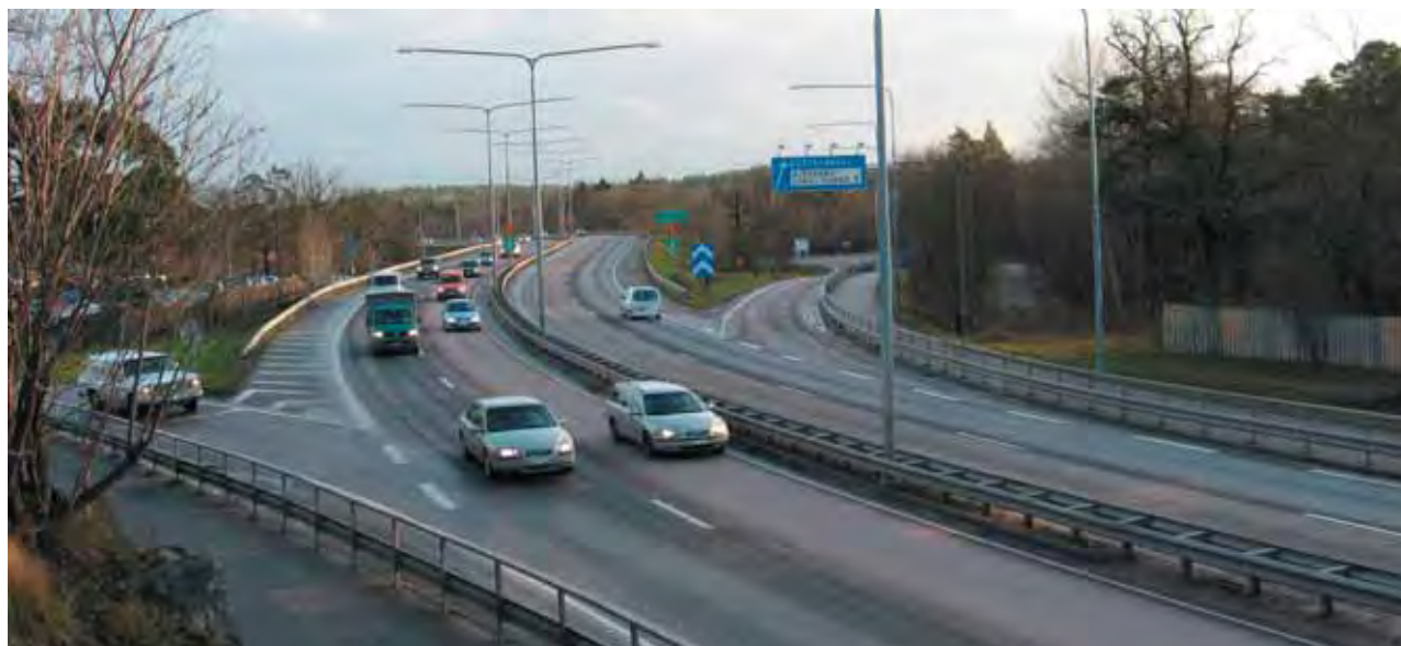
"Mainline metering" innebär att påfartstrafiken prioriteras framför den genomgående trafiken på Värmdöleden
