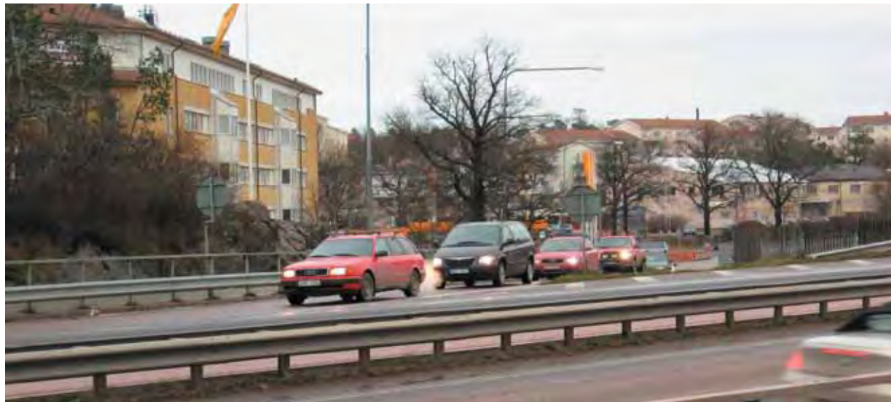
Framkomligheten och trafiksäkerheten är bristfällig i påfarten från Björknäs upp på Värmdöleden
