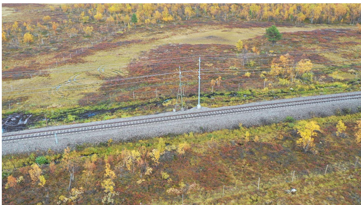
Figur 5. Vid läget för den planerade faunapassagen går Malmbanan på en låg bank som når 1 - 2,5 meter ovan omgivande mark. Vy mot öster från filmning med drönare hösten 2020.
