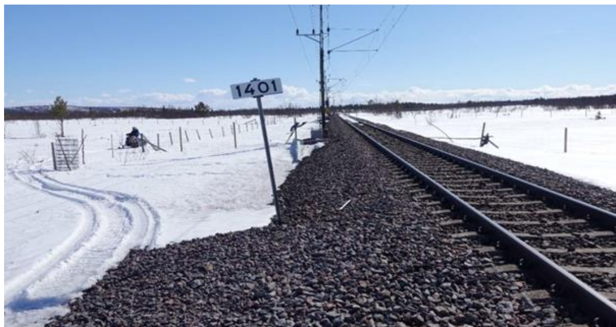
Figur 4. Vy mot söder över Malmbanan vid kilometertal 1401. Hoprullat stängsel för att möjliggöra passage för renar syns till vänster i bild. Bild från Trafikverkets rapport Teknisk studie för järnvägsplan. 2021-02-16.
