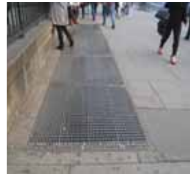
FIGUR 7.52. Exempel tryckutjämnings-schakt i marknivå, NYC.
