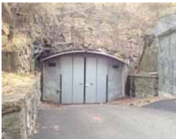
FIGUR 6.36. Foto som visar tunnelmynning Kvarnberget. Befintligt utseende.
