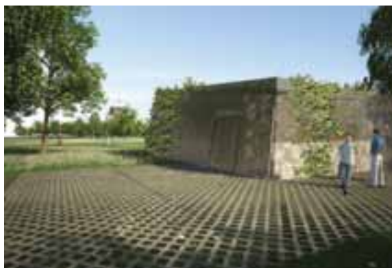
FIGUR 4.41. Illustrationsexempel som visar serviceschaktet i marknivå. Betongkonstruktionen inklusive översvämningsskyddet omsluts av en bevuxen skalkonstruktion.
