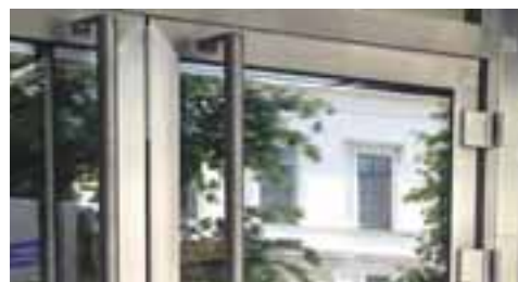
FIGUR 7.16. Rostfritt stål används i glaspartier och dörrar.
