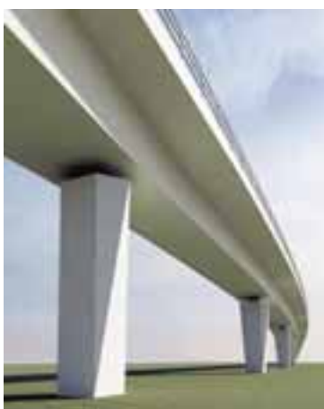
FIGUR 4.12. Princip för brostöd. Även dessa får prismatiskt fasade hörn.
