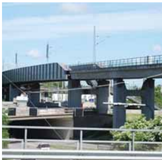
FIGUR 4.8. Godstågsviadukten sedd från Redbergsvägen i söder.
