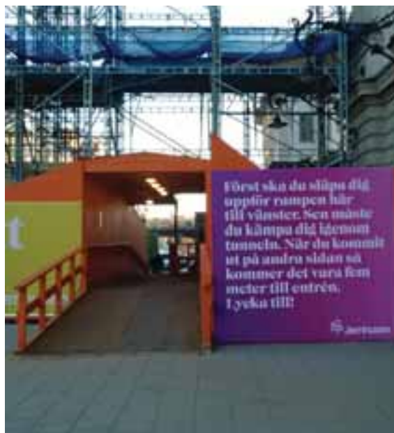
FIGUR 8.22. Entréer och målpunkter kan bli skymda under byggtiden. Den här typen av vägvisning gör det kanske inte lättare att hitta, men muntrar upp, Stockholm. Foto: Ramböll
