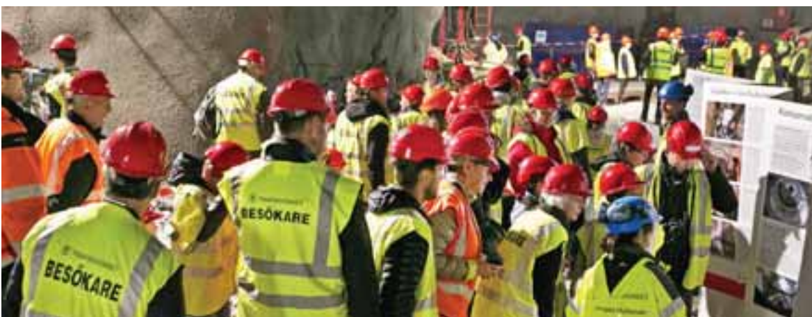
FIGUR 8.21. Visningar av arbetsplatserna är ofta välbesökta. Det kräver att utrymme för utställning, toaletter och skyddsutrustning för besökande planeras in, Citybanan, Stockholm.
