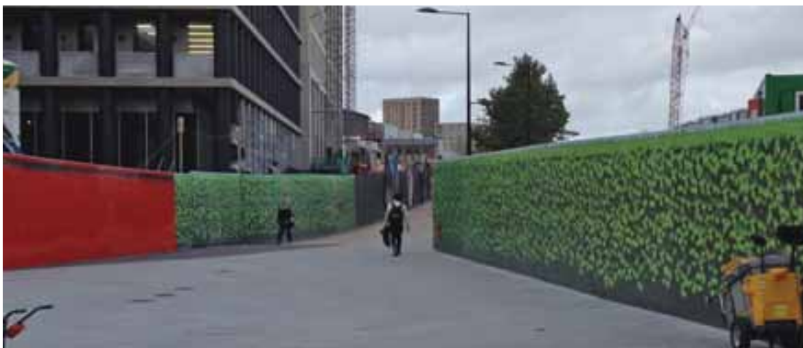
FIGUR 8.16. Faluröda plank och gröna "häckar" leder gångtrafikanter genom byggarbetsplatsen, London.
