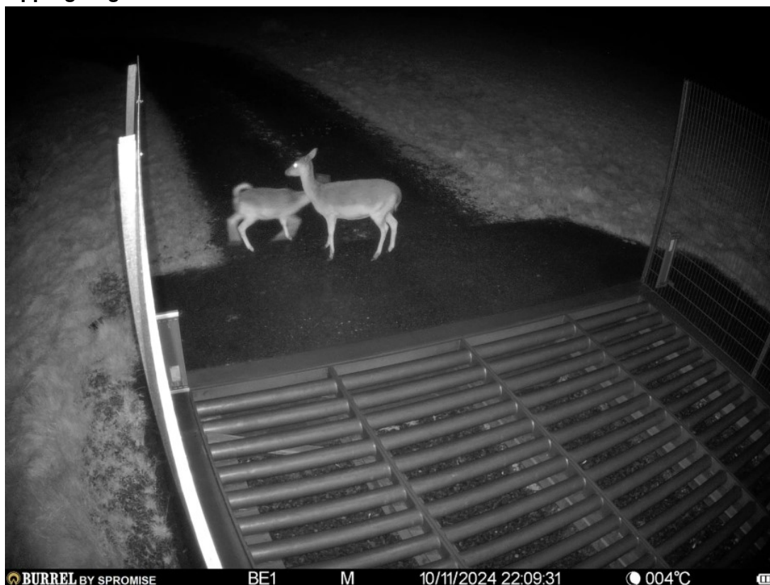
Figur 7. Bild som visar ungefärlig kameravy som behövs för att studera djurens nyttjande av färister. Kameran är riktad mot natursidan utanför färisten. Dessa dovhjortar står ungefär 1 meter från färisten. Liknande kamerauppsättning kan användas för de förstudier som planeras.
