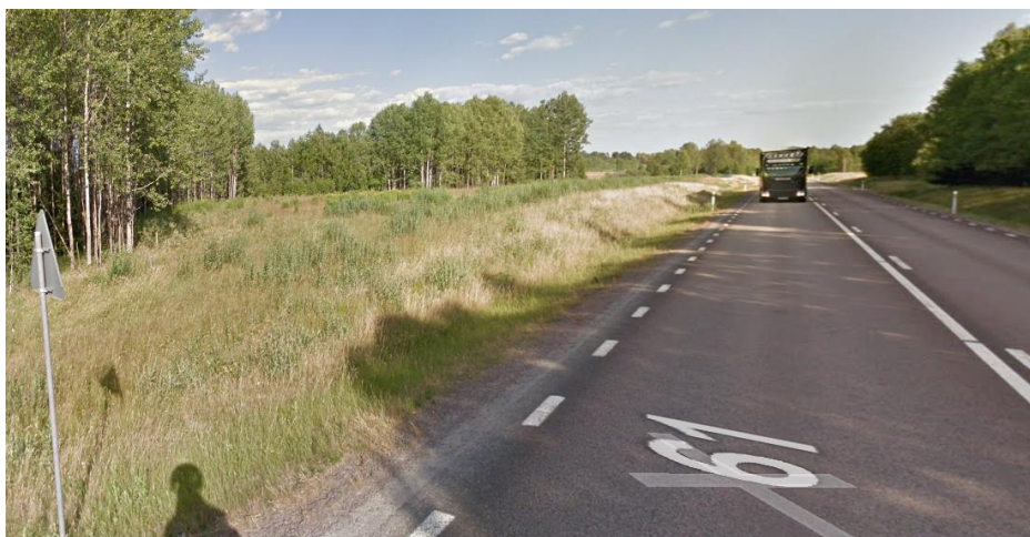
Figur 8: Vy mot sydost och befintlig slänt.
