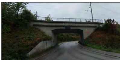
Figur 3.3:9 Bro över väg vid Hemmanet. Vy mot väster, foto från BaTMan.
