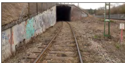
Figur 3.3:13 Bro över fabrikkspår vid Stockvik. Vy mot öster, foto från BaTMan.
