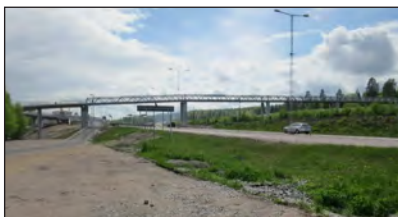
Figur 3.3:17 Gång- och cykelbro över allmän väg och järnväg (OKB) vid Bredsand. Vy mot söder, foto från BaTMan.
