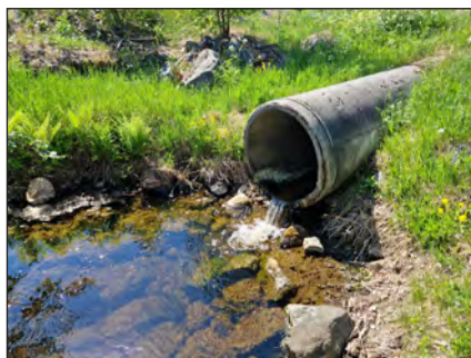
Figur 8.10:15 Den 280 meter långa kulvertens utlopp med ett cirka två decimeter högt stalp.
