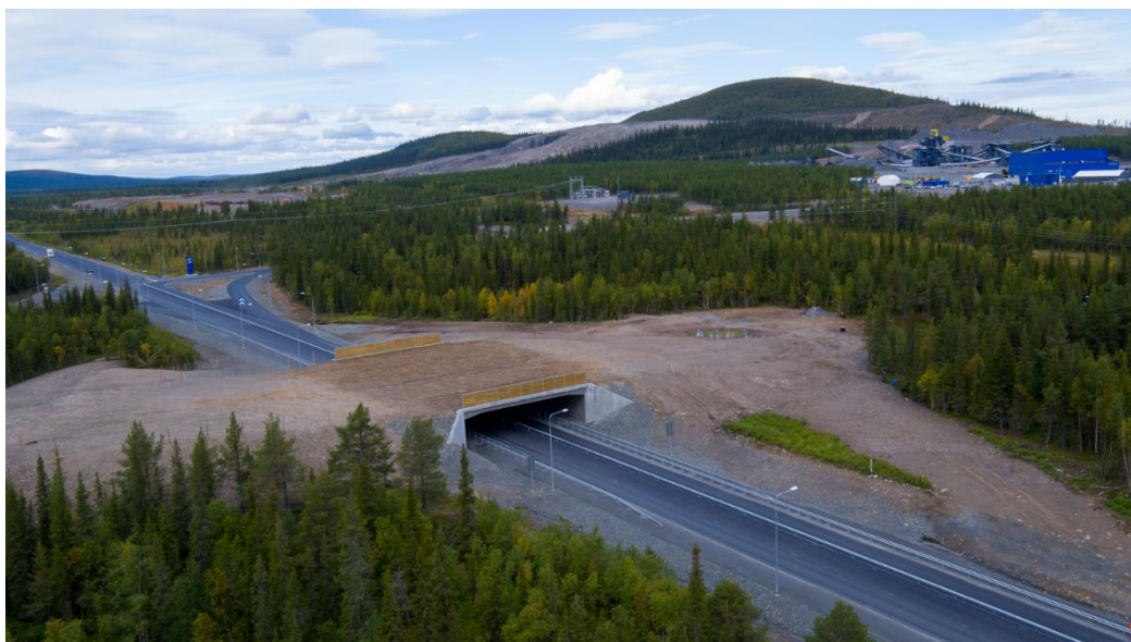
Figur 15. Exempel på planskild faunapassage. Bilden visar en 50 m bred faunabro över E10 Svappavaara (foto från BatMan).
