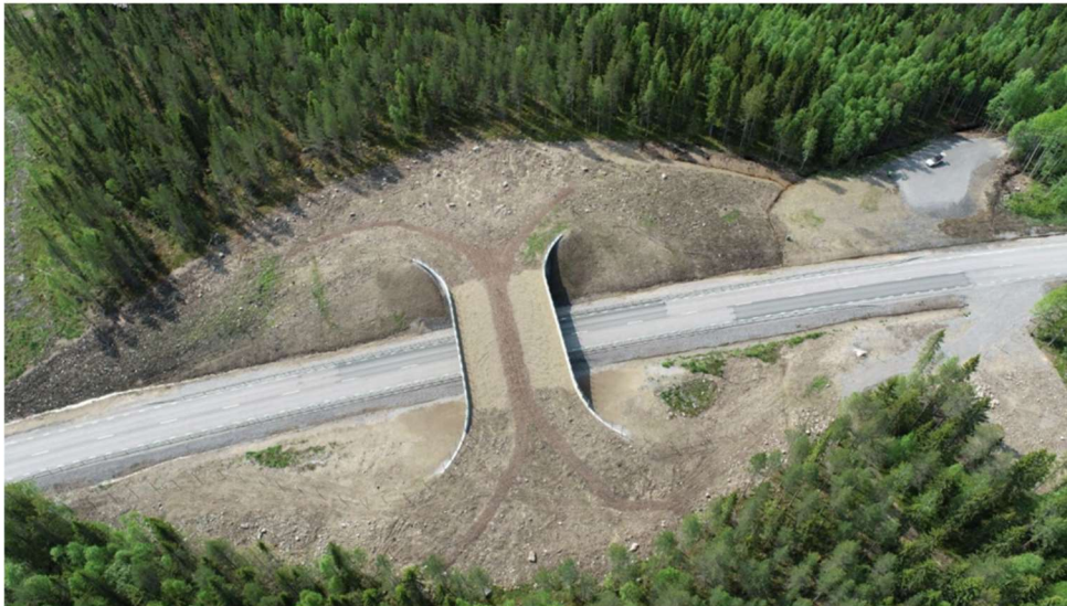
Figur 17. Exempel på faunabro. Bilden visar en faunabro över E4 vid Bredviksheden under byggtiden.
