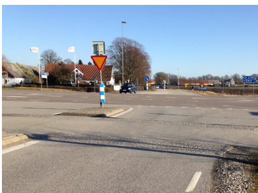
Figur 15 Passage Väståkravägen, vy mot väg 852.
