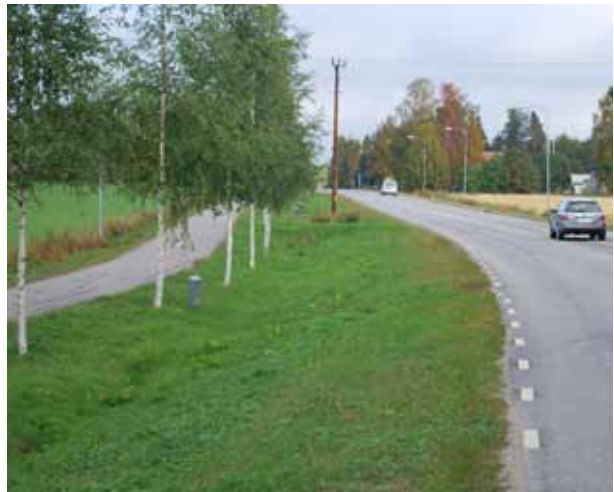
Figur 4.2.4 Cykelväg längs väg 503 norr om Vårdcentralen, Hortlax
