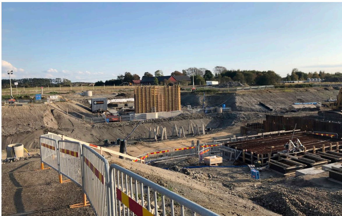
Figur 46 Projekt Varbergstunneln. Byggnation av vägbro.
