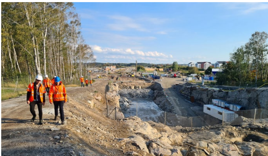
Figur 47 Dubbelspårsutbyggnad i Varberg, tunnelymning.
