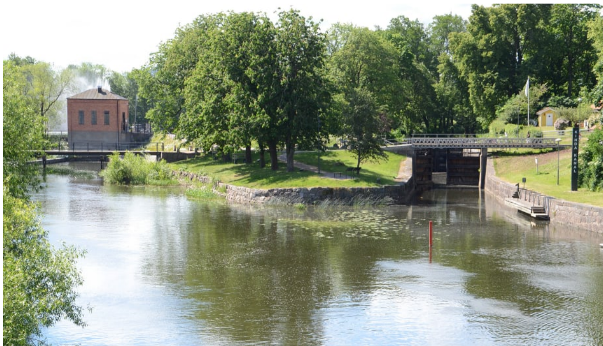
Figur 87 Nykvarn källa. (Källa: Tyréns).
