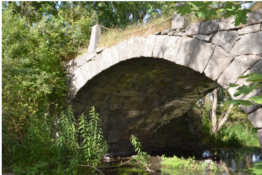
Landsvägen med grund i Eriksgatan gick tidigare över Stenvalvsbron vid Bjursholmen. Stenvalvsbron möjliggjorde passage över Sviestadån. Här låg också Bjurholmskrog
