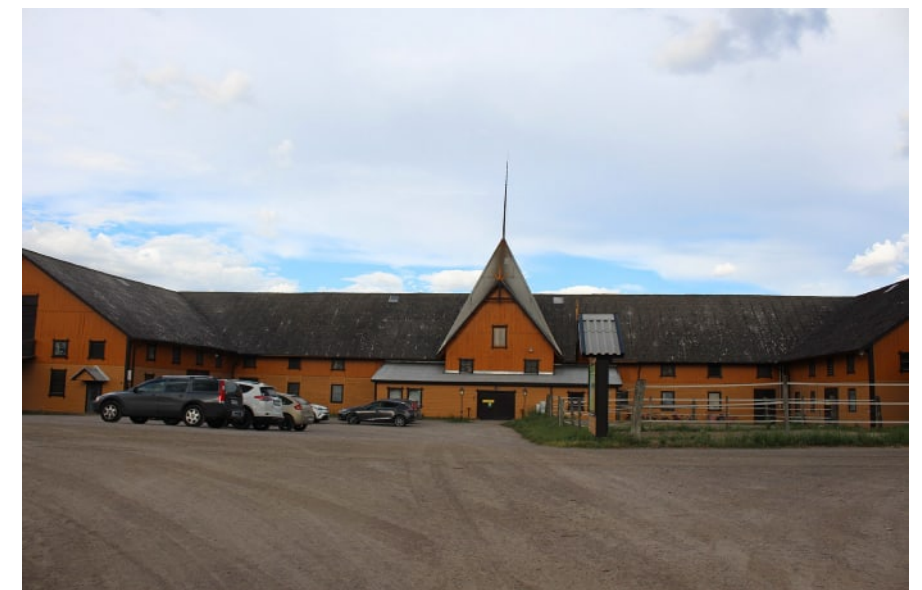
Den stora ekonomibyggnaden vid Tjärarp.
