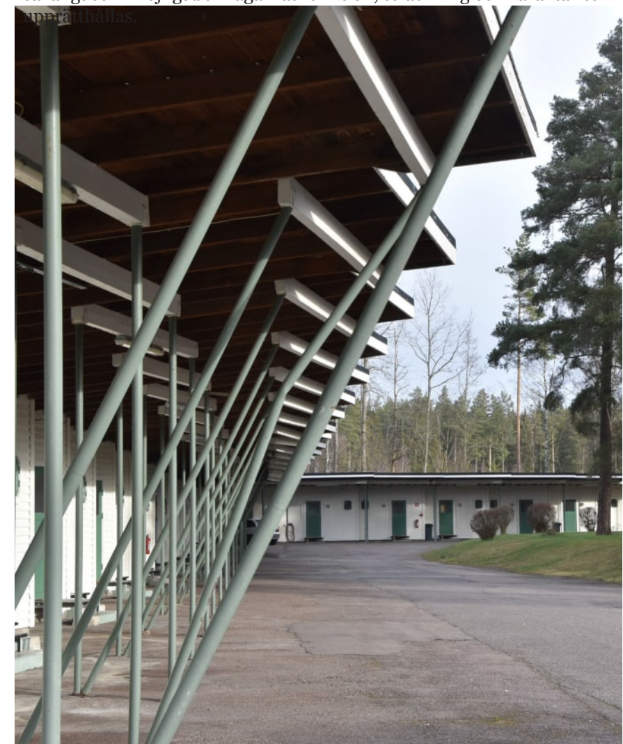
Sjögestad motell från 1954 med möjligheten att parkera utanför dörren. Fint samspel i kontrasten mellan låga byggnader och de vertikala linjerna i takstöd och tallar.
