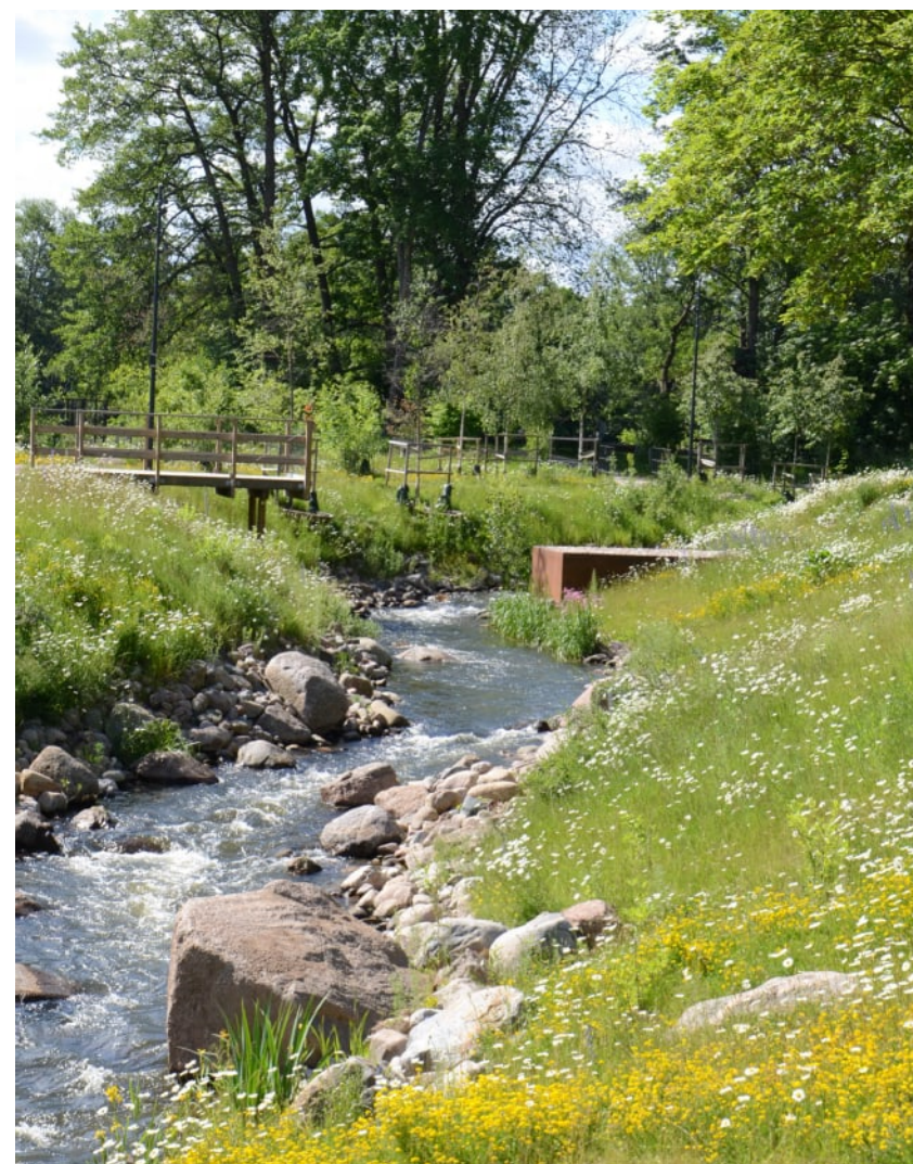
Ovan: Ett omlöp vid Nykvarn är framdraget för att agera fiskväg.
