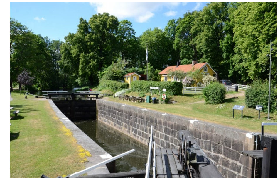
Slussen och slussvaktarbostaden.
