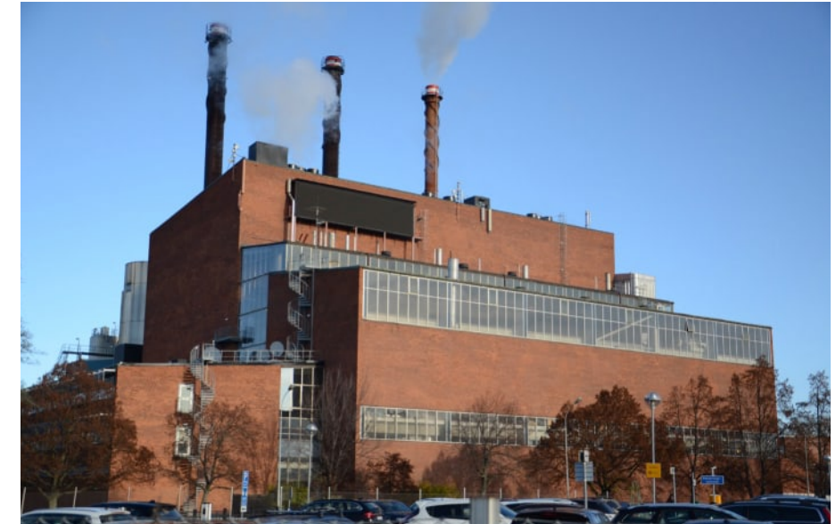
Värmevärmeverket uppfördes på tidigare Gasverkets område. Byggnaden är från 1961.
