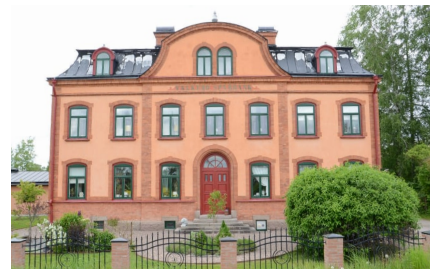
Valkebo sparkbankshuset uppfört 1902.
