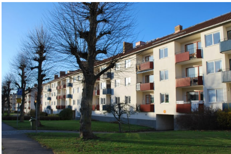
Lamellhus i den västra ytterstaden.
