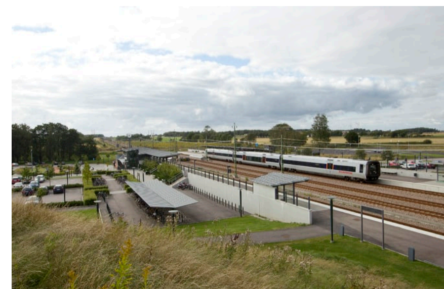
Figur 3.17. Exempel på externt läge: Falkenberg station.
