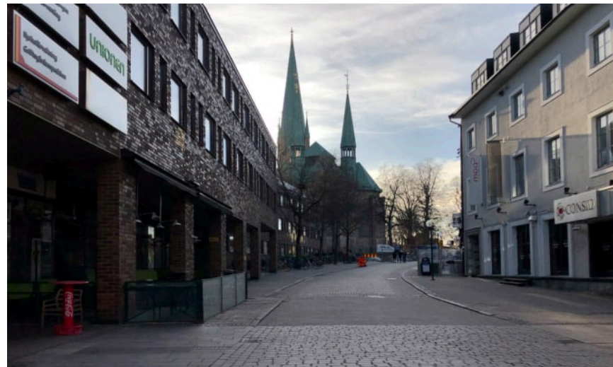
Figur 4.21. Linköpings innerstad från Ågatan upp mot Domkyrkan.
