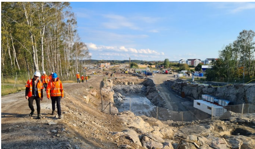
Figur 47 Dubbelspårsutbyggnad i Varberg, tunnelmynning.
