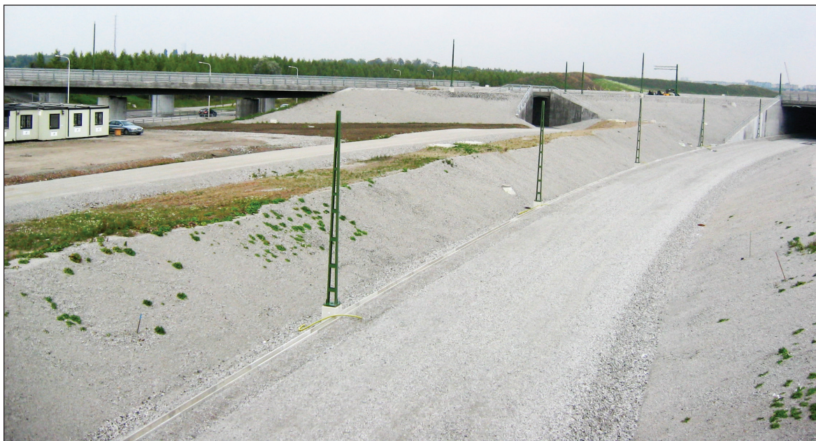
Figur 6.1 Innan en järnväg är färdigställd krävs ett mycket omfattande arbete under byggtiden.
