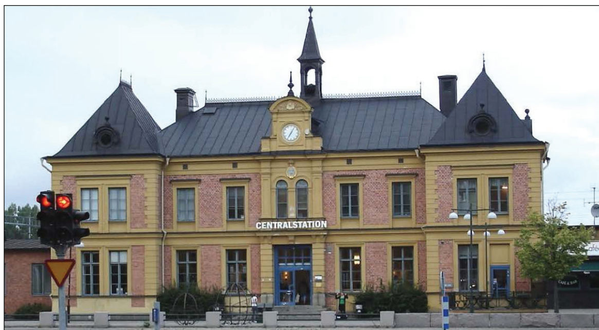
Figur 2.14 Den befintliga stationen i Linköping. Foto: Linköpings kommun 2013.
