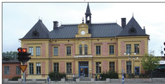
Figur 2.3 Befintligt stationshus i Linköping. Foto: Linköpings kommun 2013.
