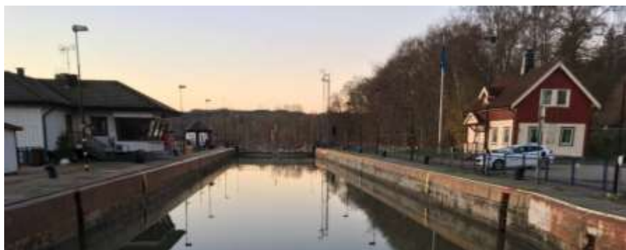
Figur 19. Befintlig sluss med omgivande bebyggelse.
