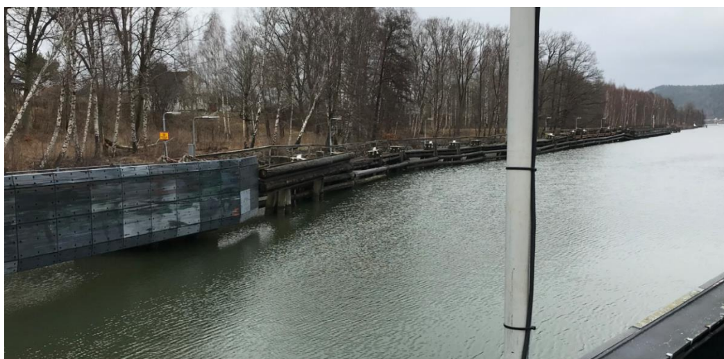
Figur 5. Västra slussinfarten uppströms slussen.
