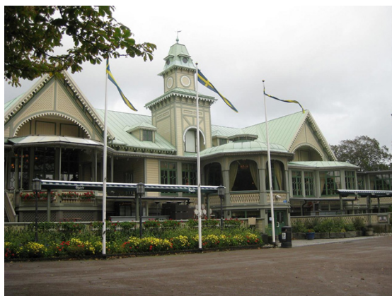
Figur 8.19 Varbergs societetshus ligger inom fästningsområdet och utgör en del av bad- och kurortens miljöer. Foto: bebyggelseinventeringen i Halland.
