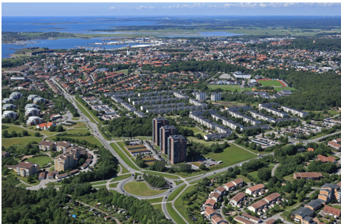
Figur 8.28 Flygbild över södra Varberg; norra Breared i förgrunden, Sörses lamellhus centralt i bild och norr om dem Mariedals villaområden. Punkthusen till vänster i bild är Apelvikhöjd.
