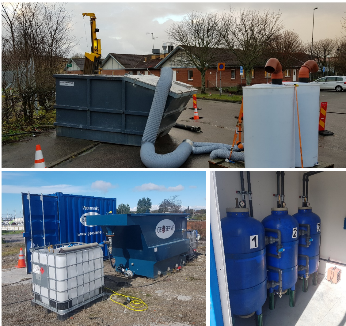
Figur 10. Överst syns den täta kaxcontainern och kolfiltren för luftreningen. Nere till vänster syns vattenreningsanläggningen och nere till höger syns kolfiltren för vattenreningen som står inne i den blå containern.
