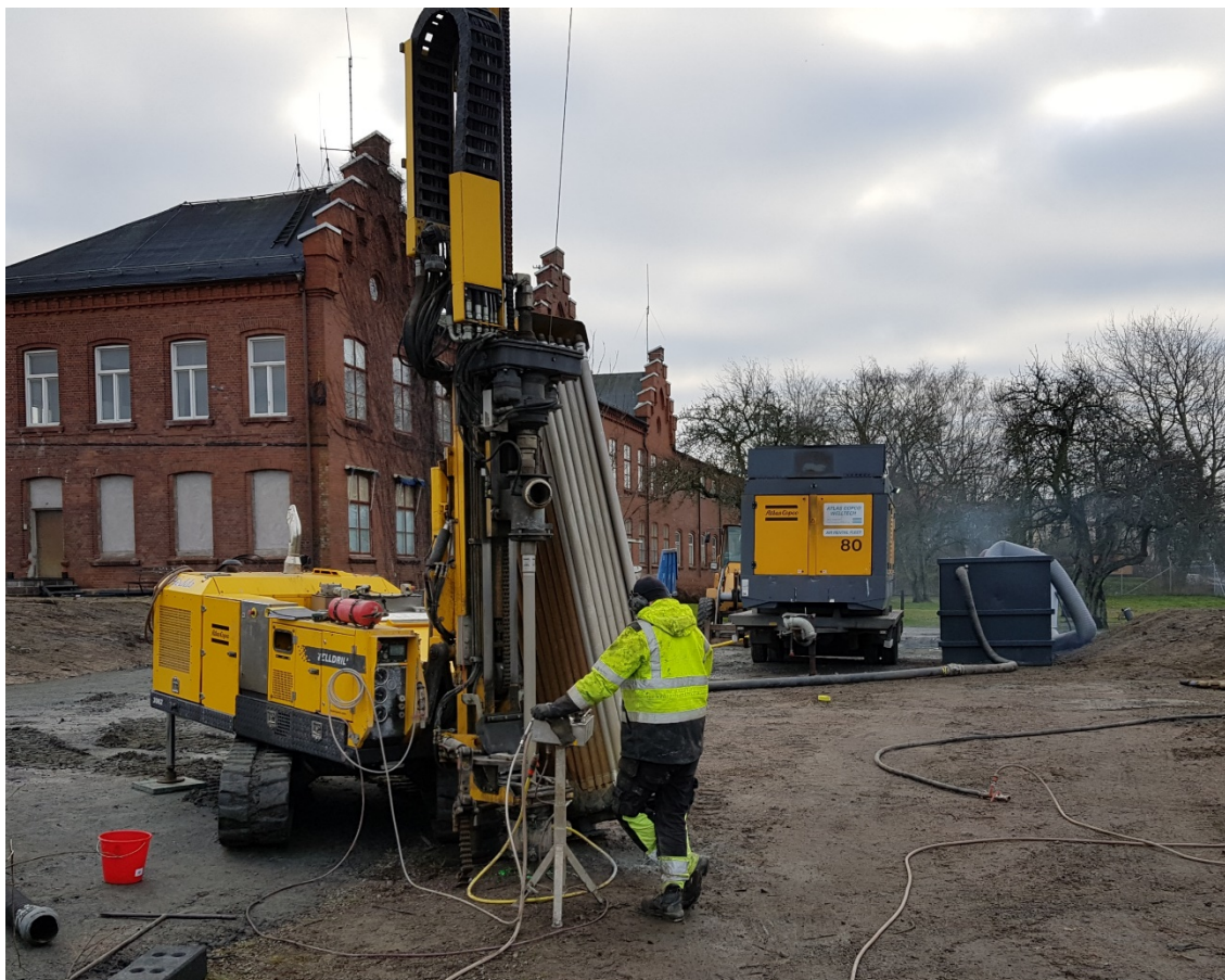
Figur 11. Exempelbild från bergborrningen i B1712.
