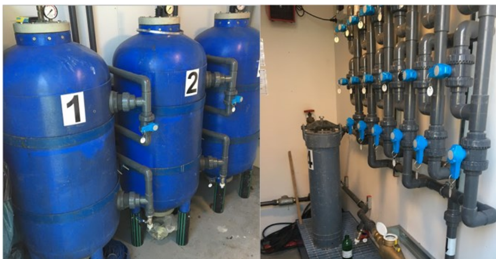
Bild 2. Den vänstra bilden visar de 3 kolfiltren och den högra bilden visar påsfiltret.
