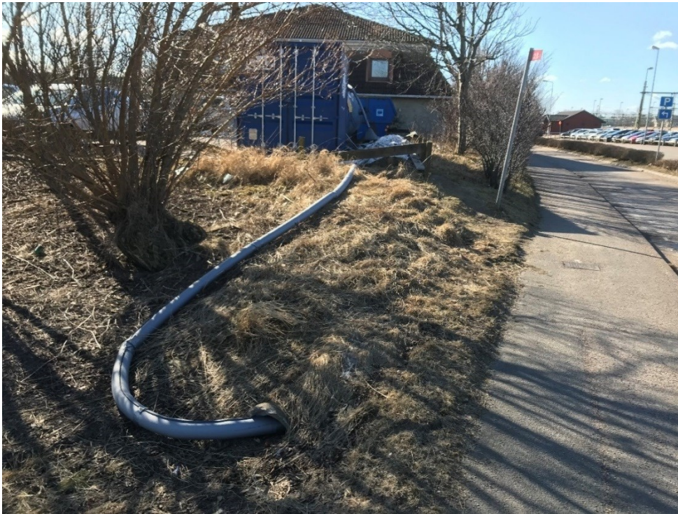
Bild 3. Utsläppspunkt för renat grundvatten. Vattnet leddes till dagvattensystemet.
