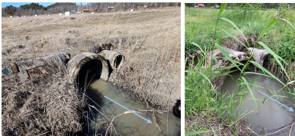
Figur 20. Foto på trummor under körväg, se Figur 18, där vattnets flödesriktning visas med blå pilar. Foto till vänster är taget 2017-03-23 (Okänd fotograf, Trafikverket, 2019). Foto till höger är taget 2021-08-26 (fotograf: Kristina Lundgren).
